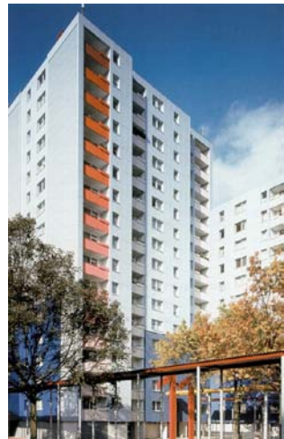
Abb. 1: Innen liegende Wohnungen benötigen bis zu 50 % weniger Energie, als außen liegende.
