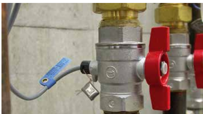
Bild 5: Kugelhahn mit integriertem Fühleranschluss M10 X 1 (im Bild Rücklauftemperatursensor eines Splitt-Wärmezählers).
