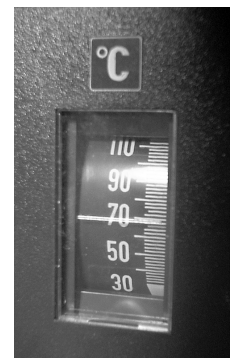
Abb. 2: Oft mit der Warmwassertemperatur verwechselt, zeigt diese Skale jedoch die Kesseltemperatur.
