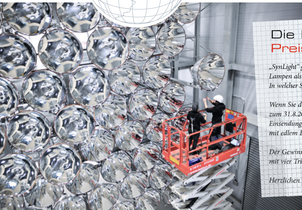
Arbeiter vor den Lampen der Super-Sonne
