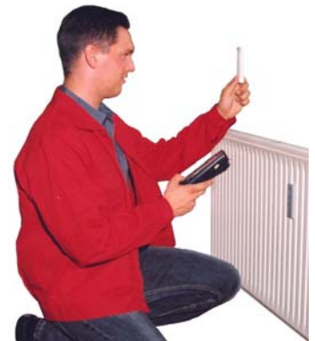
Abb. 1: Der Ableser des Messdienstes hält das Vorderteil des Heizkostenverteilers gegen das Licht, um den Ablesepunkt genau erkennen zu können.
