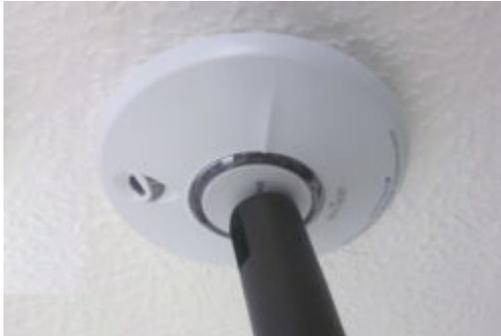
Bei einem unerwünschten Alarm ausgelöst durch Küchen-oder Wasserdämpfe, kann der Rauchwarnmelder bequem über die Alarm-Stopp-Taste für ca. 10 min. „Stumm“-geschaltet werden. Dies ist z.B. mit einem Besenstiel sehr einfach möglich. Die Stummschaltung reduziert die Ansprechempfindlichkeit des Rauchwarnmelders. Trotzdem ist der Rauchwarnmelder noch aktiv! Bei Stummschaltung bei Fehlalarm erfolgt ein Reset bereits nach 10 Minuten! Der Normalzustand ist wieder hergestellt.
