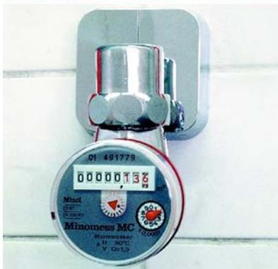
Abb. 4: Die Modernisierung der alten Warmwasserkostenverteiler ist einfach und ohne Eingriff an der Leitungsführung möglich. Dazu wird lediglich der ursprünglicher Verteiler demontiert. Mit einem speziellen Bohrverfahren wird das vorhandene Venturi-T-Stück dann für die Montage des geeichten Warmwasserzählers MINOCONTROL vorbereitet.
