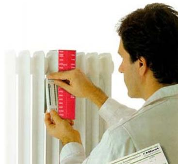
wird im Rahmen der Heizkörperidentifizierung jeder Heizkörpertyp zusätzlich fotografiert und alle Heizkörpermaße werden einzeln ermittelt. Falls erforderlich, entwickeln wir im eigenen Labor auf einem Heizkörperleistungs- und C-Wert-Prüfstand auch Methoden für Sondermontagen. Für jede Nutzeinheit erhalten Sie ein Technisches Grunddatenblatt mit allen Heizkörperdaten und den ermittelten Bewertungsfaktoren. Das schafft Vertrauen durch Transparenz und Datenoffenlegung.
