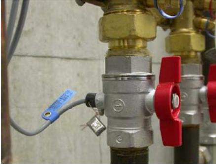
Abb. 3: Für die Neuinstallation von Temperaturfühlern für Wärmezähler in Rohrleitungen kleiner oder gleich DN25 gilt seit 2007 eine neue Regelung: Die Fühler müssen direkt in das Heizmedium tauchen. Die früher üblichen Tauchhülsen dürfen nur noch bei Bestandsanlagen verwendet werden. In der Praxis bedeutet das die Verwendung von Kugelhähnen für den direkten Fühlereinbau oder einer gleichwertigen Einbaustelle.
