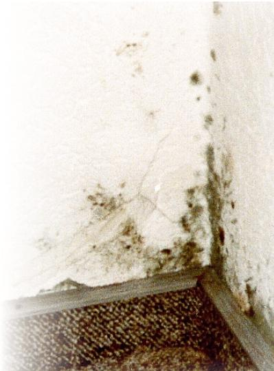
Abb. 5: Wegen der geringeren Dichte von tragenden Böden und Decken entstehen besonders dort Wärmebrücken. Bei fehlender Belüftung bildet sich zuerst Feuchtigkeit und dann Schimmel.
