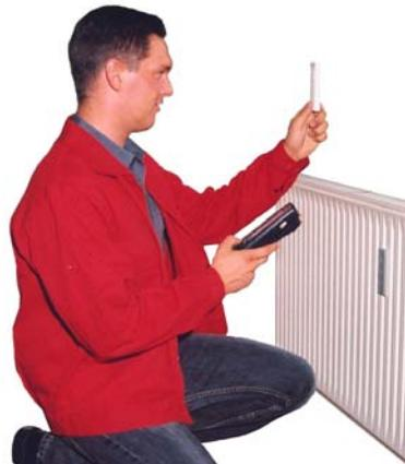
Abb. 1: Der Ableiter des Messdienstes hält das Vorderteil des Heizkostenverteilers gegen das Licht, um den Ableitpunkt genau erkennen zu können.
