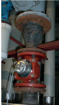
Foto 1 und 1a: Fehlende Beruhigungsstrecke vor einem Woltmanzähler entgegen Anforderungen des Geräteherstellers
